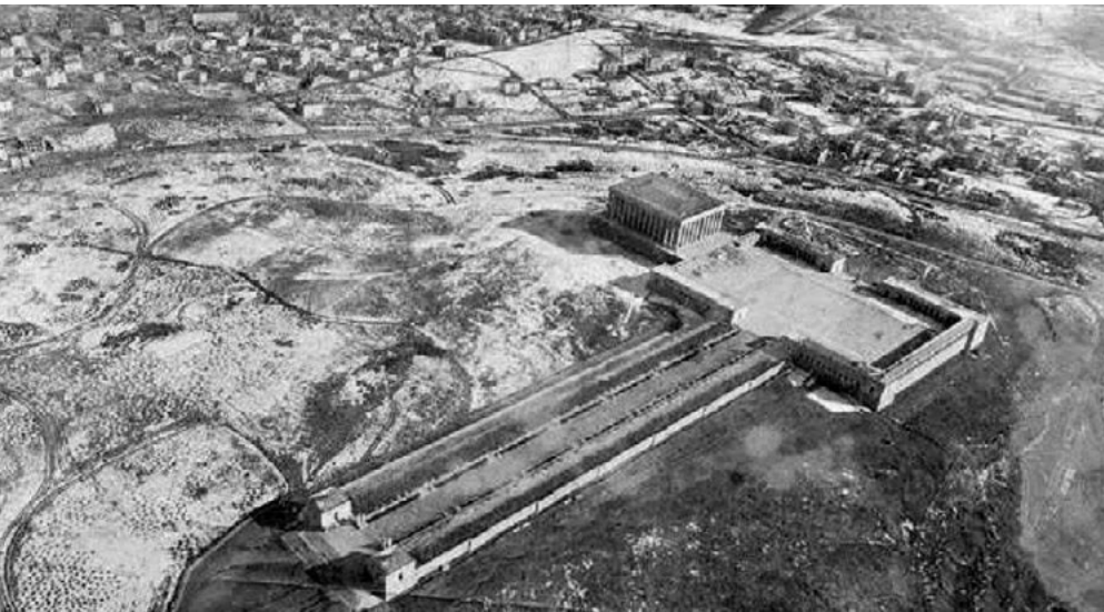
➤ Anıtkabir inşaatının tepeden görünümü
