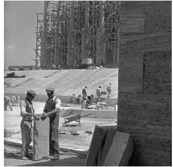
↗ Anıtkabir inşaatı sırasında işçiler
