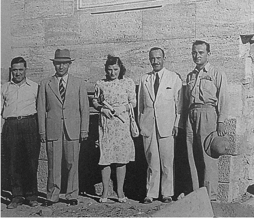
« Türkiye'nin ilk kadın mühendislerinden Sabiha Rifat Gürayman ve Orhan Arda Anıtkabir inşaatında. Fotoğraf; Uğur Tanyeli, Mimarlığın Aktörleri Türkiye 1900-2000 kitabından alınmıştır.
