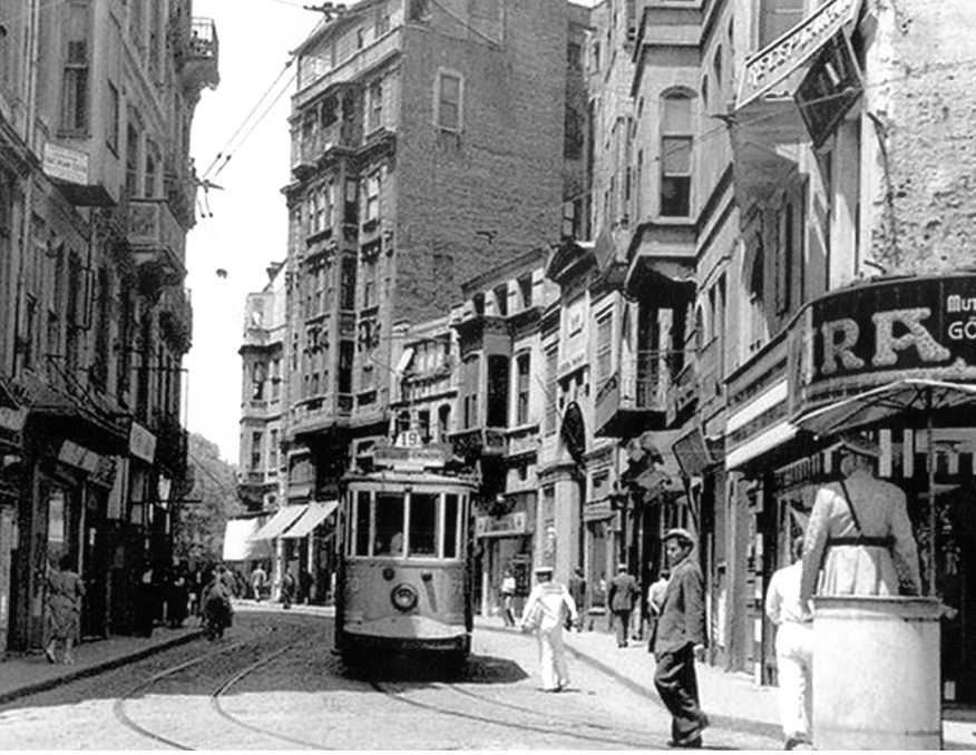
⚡ Krepen Pasajı'nın bilinen tek fotoğrafı (Tramway boynuzunun arkasında kalan yapı)
