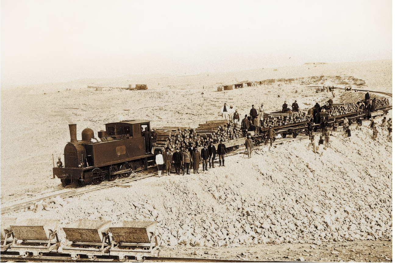
⚡ Sultan II. Abdülhamid döneminde Şam ile Medine arasında inşa edilen Hicaz Demiryolu'nda, ahşap traversleri yapım noktasına taşıyan bir iş treni ve hatta görev alan işçiler.
