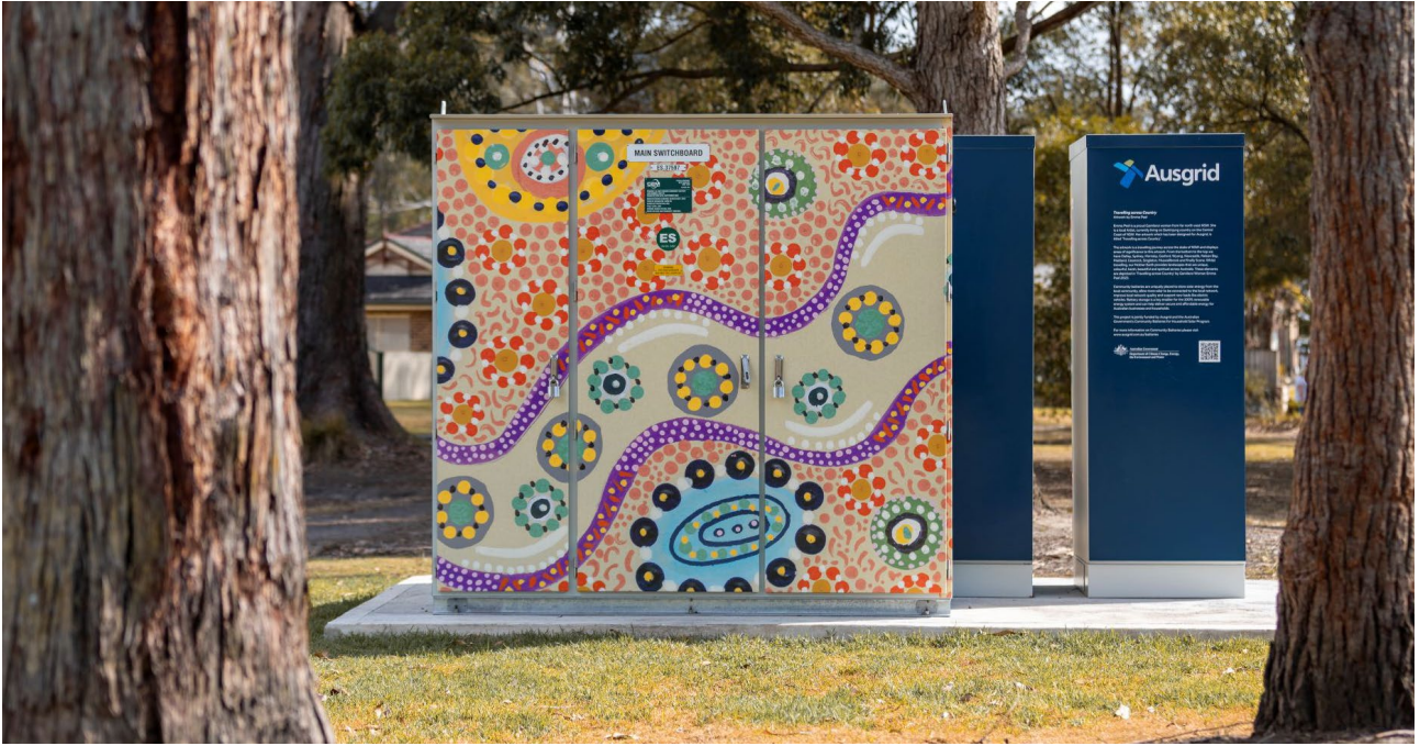
⚡ Mahallede ortak pil: Çevredeki güneş panellerinden elde edilen fazla elektriği depolayarak abonelere dağıtıyor.
