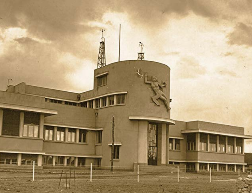
△ Theodor Jost ve Robert Oerley tarafından inşa edilen Hıfzısıhha Enstitüsü
